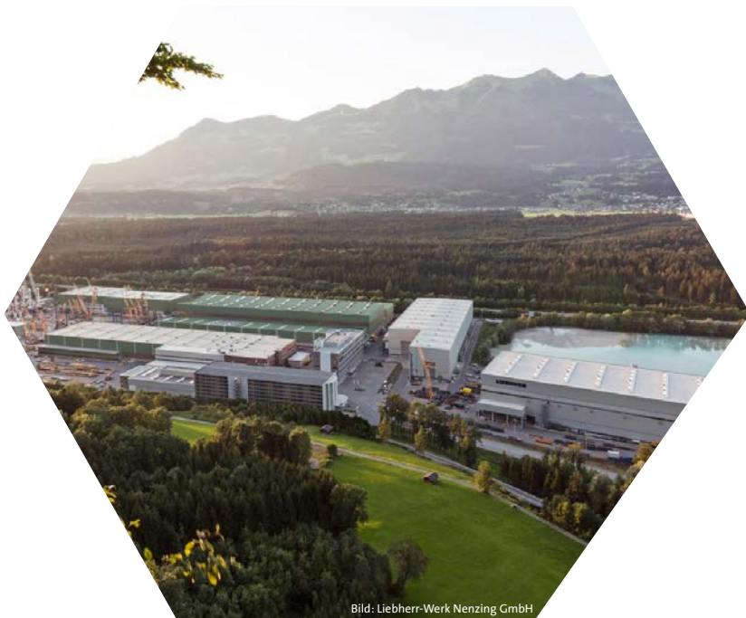
Bild: Liebherr-Werk Nenzing GmbH
